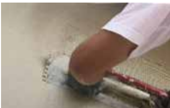
Innsparkling av fiberduk i forsterkningen Fixit 223
