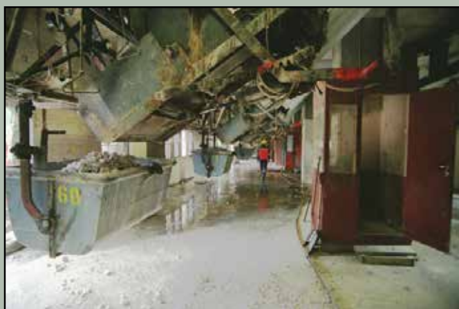
Fylling av kalkstein i vagger. (005-i-os-f02-07.jpg)
