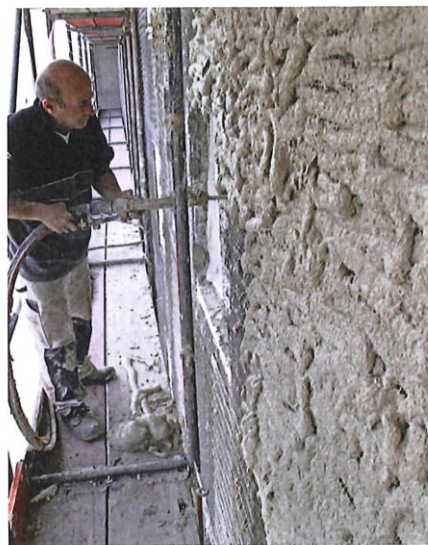
Isoleringspussen påføres med maskin. I dette tilfellet sørger en pussbærenetting for mer sikkerhet.
