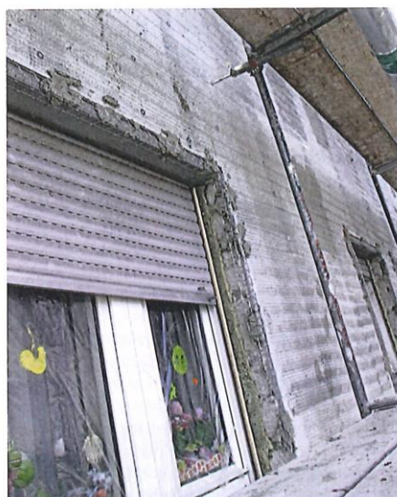
Hjørneprofiler sørger for eksakte kanter og for korrekt isoleringstykkelse
