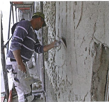
Isoleringspussen glattes ut. Armert forsterkningsmørtel påføres etter dette.
